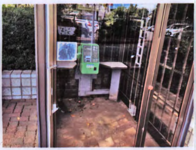
車椅子対応型...⑥ 手すりが設置されている 椅子が設置されている
